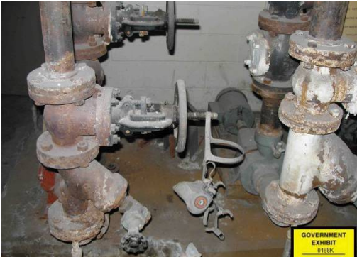
Asbestos-Laden Pipe
